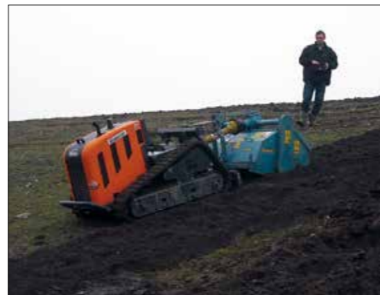
Bodenfräse im Deichbereich
